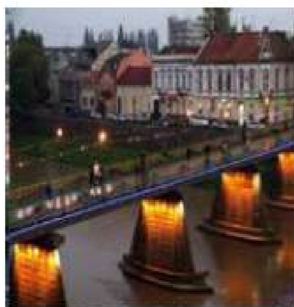
Пішохідний міст в м. Ужгороді
